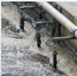
(Abb. 3) Installierte IQ Sensoren für Nitrat, Ammonium und Sauerstoff im Belebungsbecken
